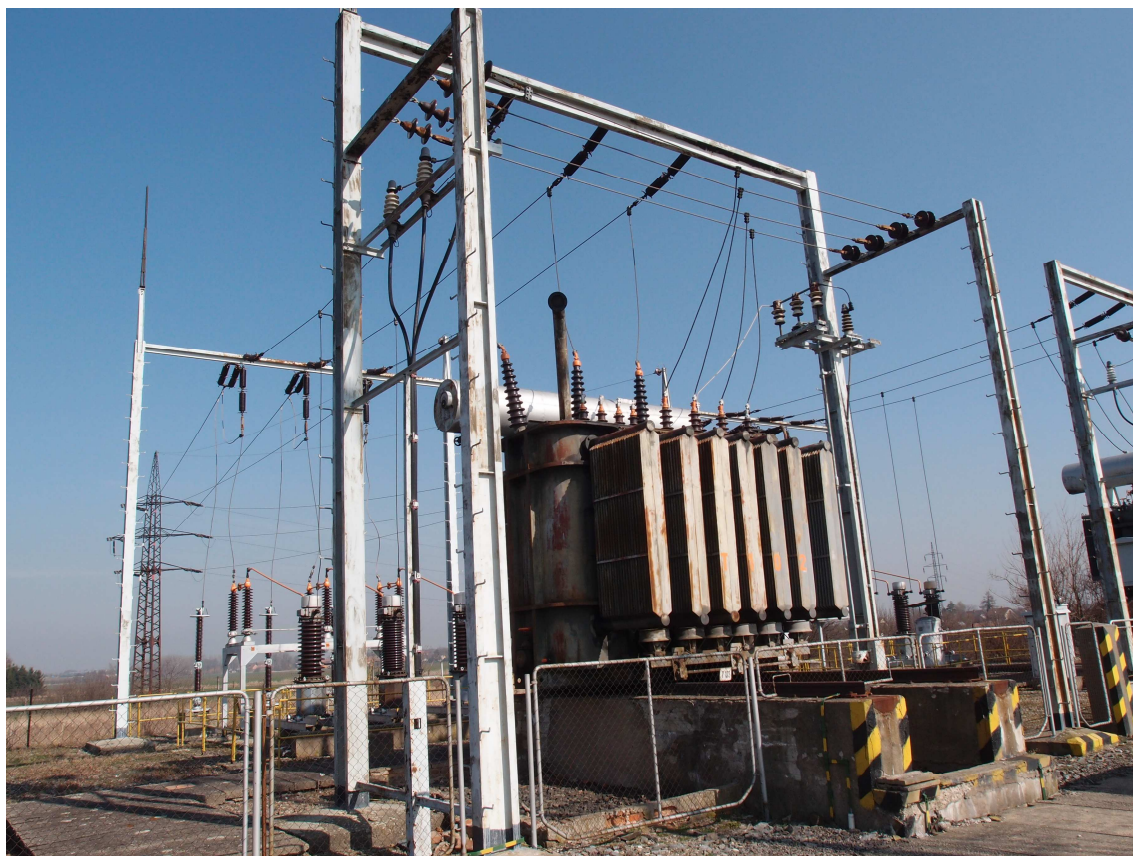
Obr. 4 – Pohled na stanoviště transformátoru T102 – 100/23 kV TNS Rostoklaty napájeného z pole linky V 961
