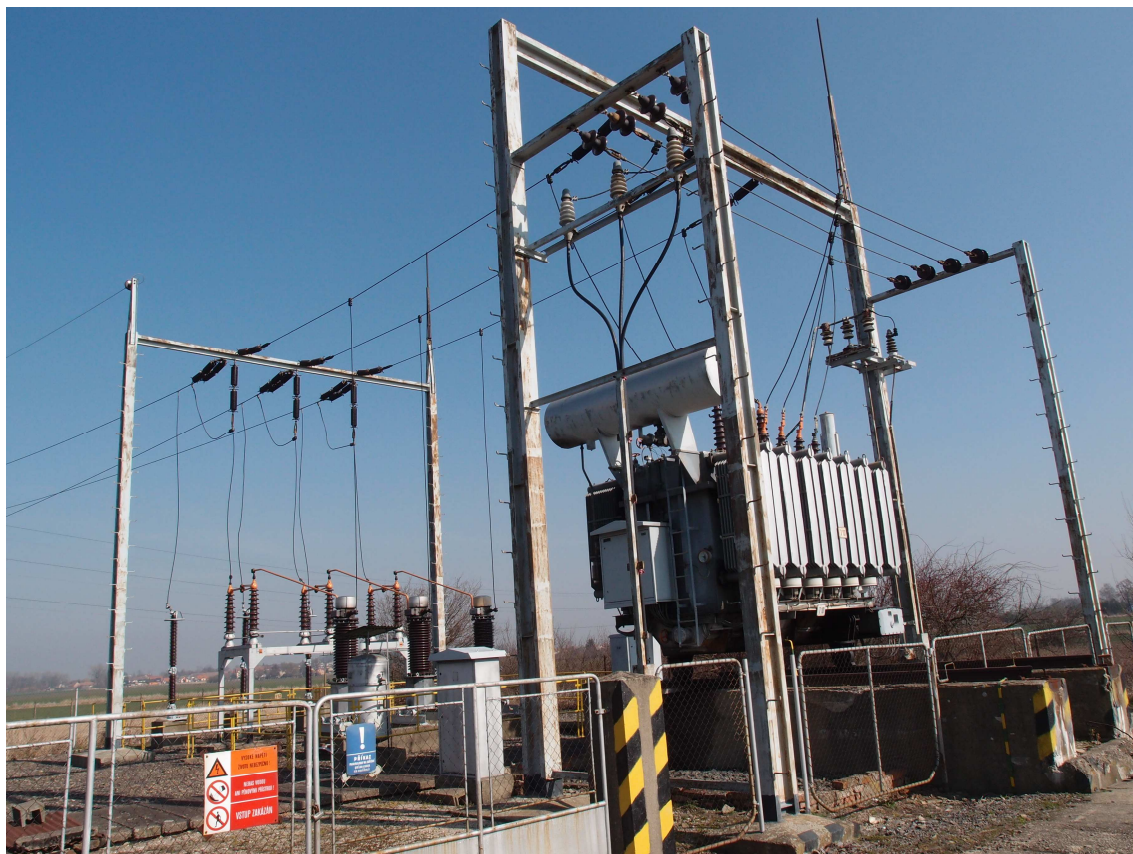
Obr. 5 – Pohled na stanoviště transformátoru T-101 - 110/23 kV TNS Rostoklaty napájeného z pole linky V 962
