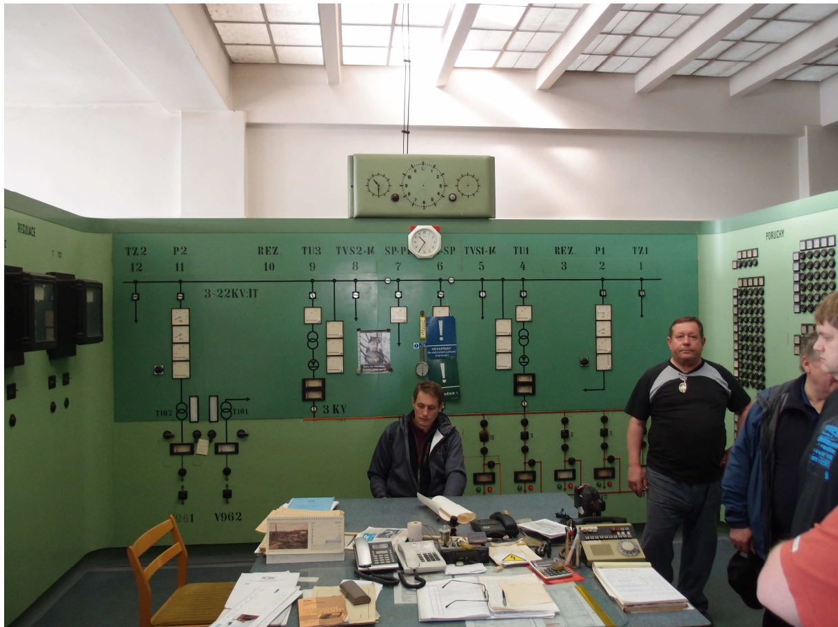
Obr. 7 – Pohled na manipulační rozvaděče na velínu v TM Rostoklaty. Vlevo dole je část pro ovládání a signalizaci rozvodny 110 kV
