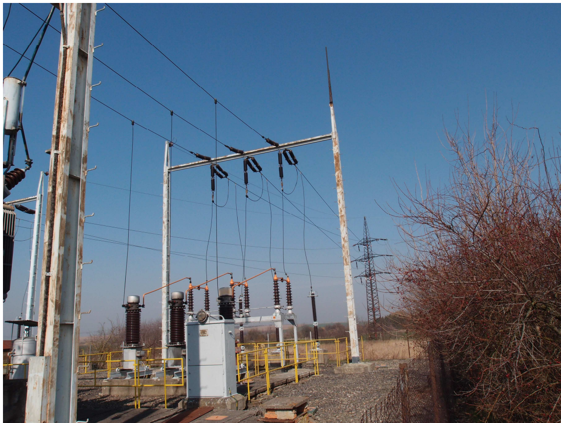
Obr. 6 – Pohled na pole linky V 962 rozvodny 110 kV TNS Rostoklaty s ovládací skříní pole
